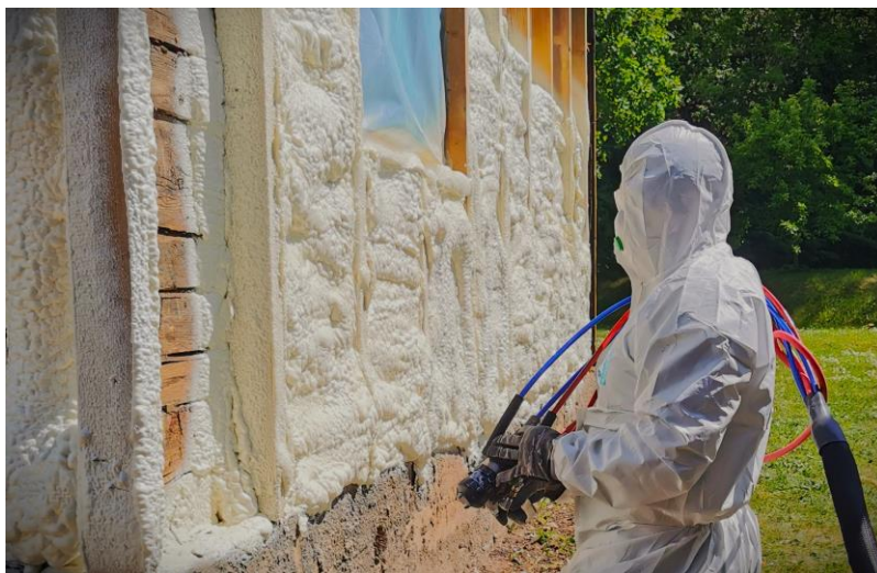
Nuotraukose įsigyta nauja šiltinimo purškiamu putų poliuretano įranga ir vykdomi pastato šiltinimo darbai.
